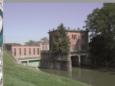
Il "Chiavicone" di S. Stefano, manufatto idraulico di deviazione dei deflussi (3). Quando i livelli bassi del Po lo consentono le acque vengono dirette immediatamente nel fiume stesso tramite lo scarico di destra. In caso contrario vengono deviate (con le paratoie di sinistra) nel canale "Allacciate" e quindi di nuovo in Po a Castelnuovo, potendo contare sul maggior dislivello disponibile. Questo accorgimento era già previsto dal progetto che l'ing. Antonio Tosi aveva elaborato nei primi anni del XX secolo.
